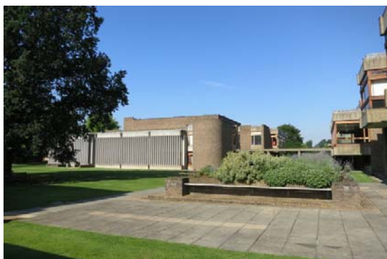
チャーチル・アーカイブ・センター外観
